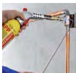
Пайка мягким припоем при монтаже системы отопления
