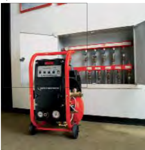
Промывка системы отопления пола
