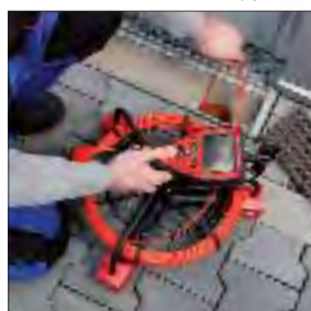
Обследование ливневых труб
